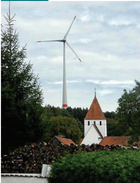
MALA VETRINA ELEKTRARNA 1 MW
